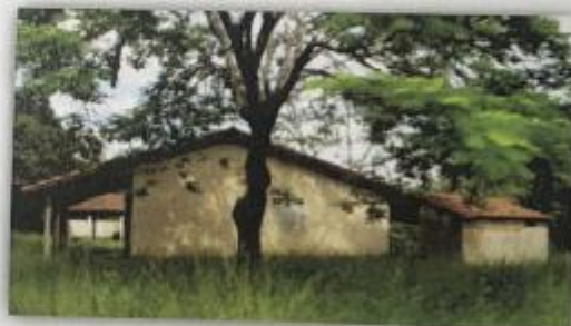
Casa 1 e ao fundo a casa 2 de 3 casas do sítio
